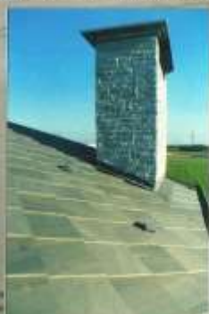
Particolare di copertura a squame tipo svizzera
