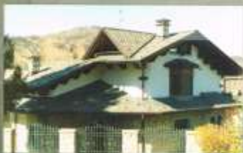
Villa in ambiente montano con copertura tipo svizzera e rivestimenti in Pietra di Orefino
