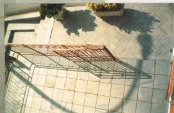
Pavimentazione a lastre quadrate e rettangolari
