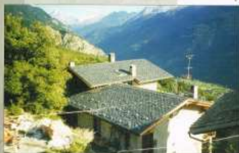
Copertura tipo bergamasca
