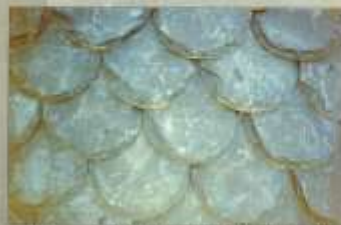
Particolare di copertura a squame tipo svizzera
