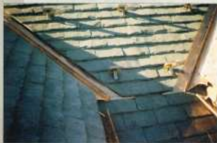
Coperture alla francese con formelle
