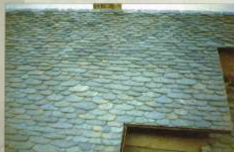
Tetto con copertura tipo rustica
