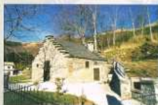
Baita ristrutturata con copertura a squame tipo svizzera
