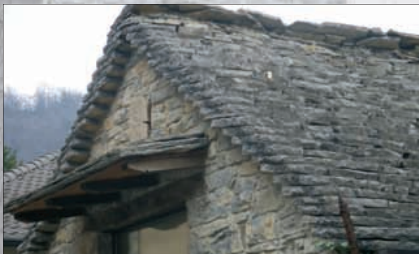
Copertura di una tipica costruzione rurale valdimagnina
