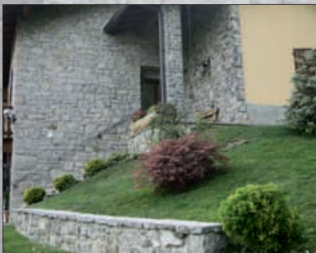
Muratura, copertine e pilastro
