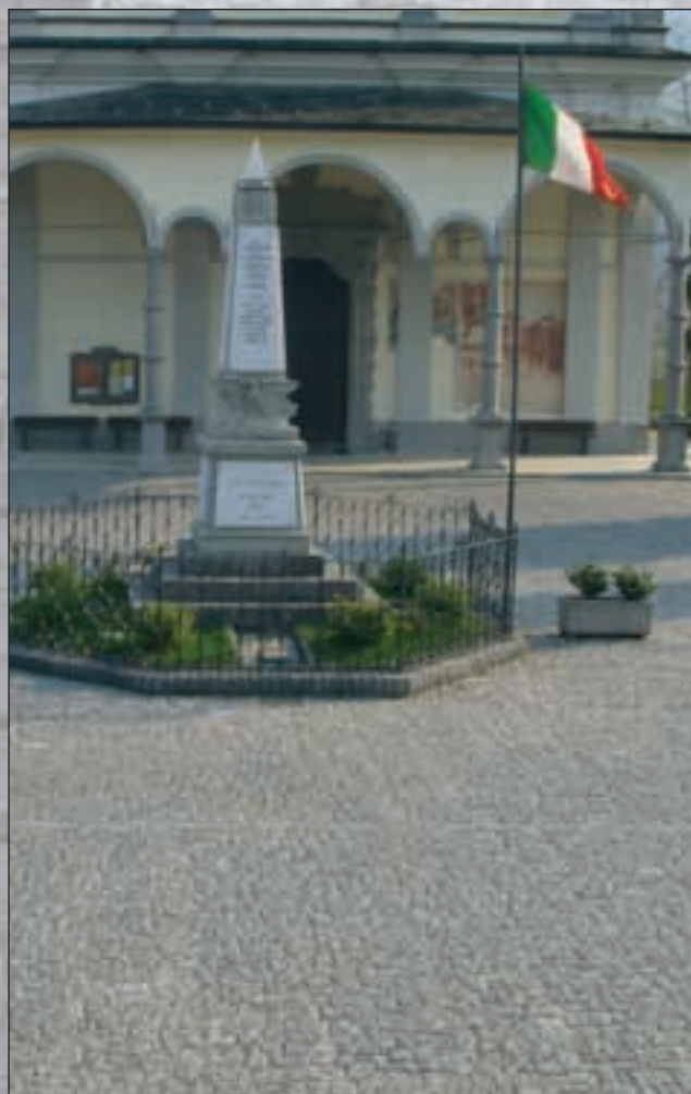
Pavimentazione a selciato
