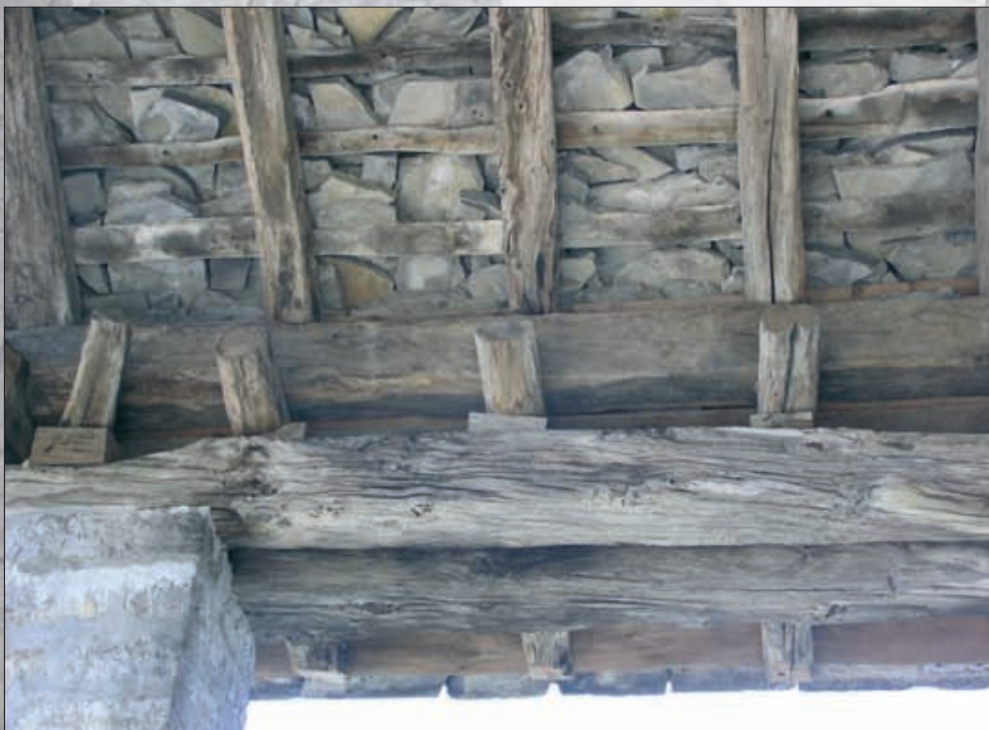
Dettaglio costruttivo: falda del tetto visto dall'interno
