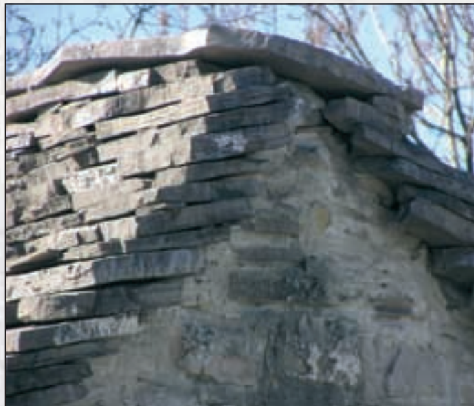
Quintana: particolare costruttivo dell'intersezione facciata-tetto
