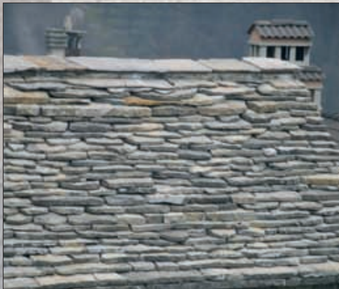
Falda realizzata con la regolare disposizione delle piöde
