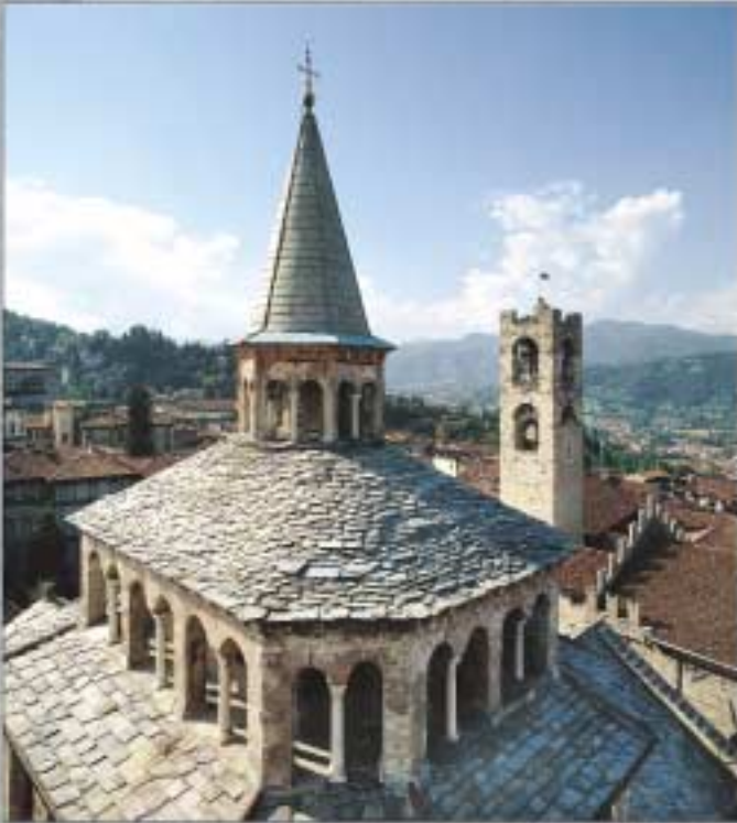
Dettaglio della cupola di Santa Maria Maggiore (Bergamo) realizzata con copertura alla bergamasca
