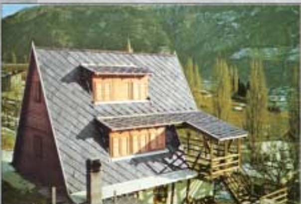
Chalet con copertura alla francese, ideale nel caso di falde molto inclinate
