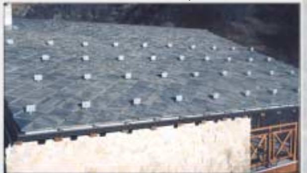
Particolare di copertura alla francese dotata di fermaneve
