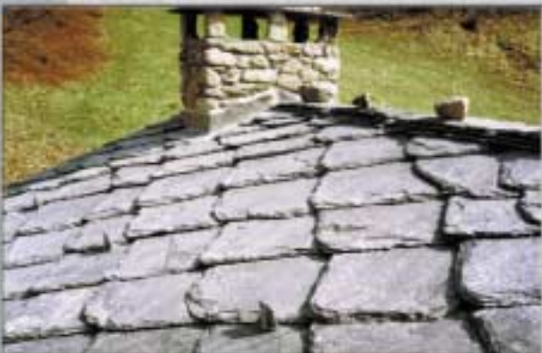
Particolare di copertura alla valdostana con colmo caratteristico
