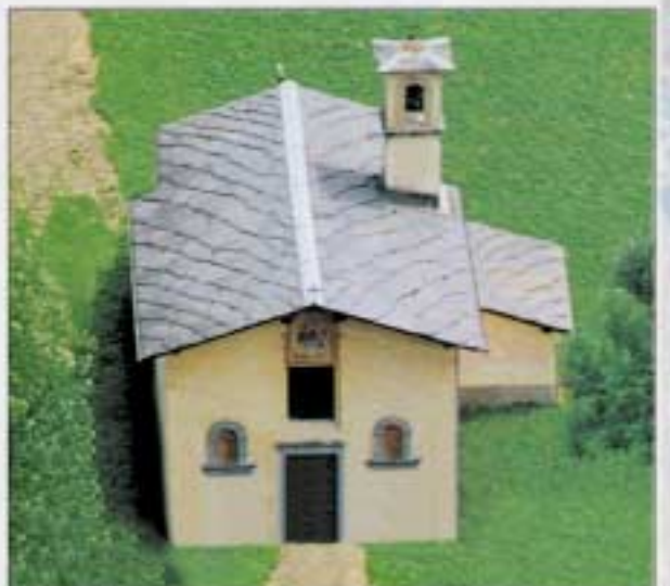
Chiesa di Santa Maria (Branzi) con copertura alla valdostana
