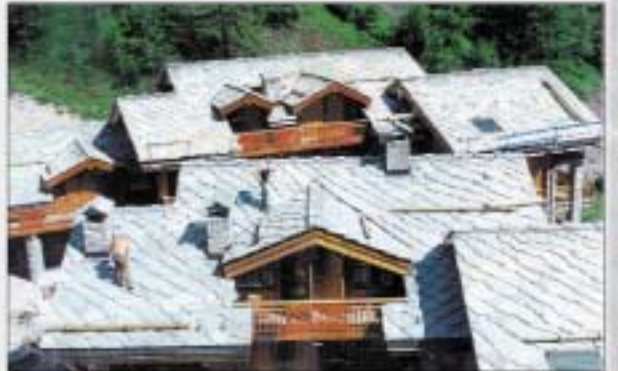
Un bell'esempio di copertura tipo valdostana
