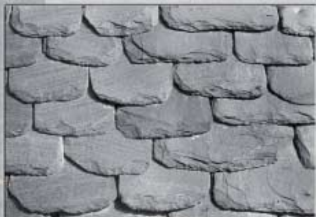
Copertura tipo Bergamasca
